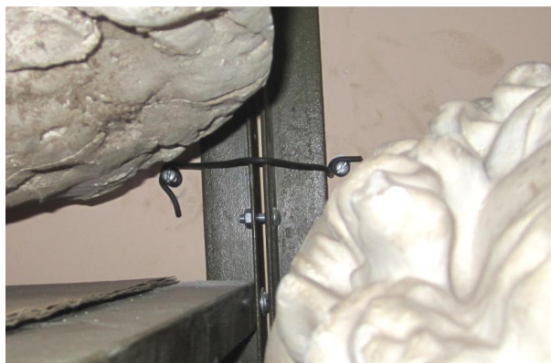
Fig. 28. Sistema de fixação das estantes.
