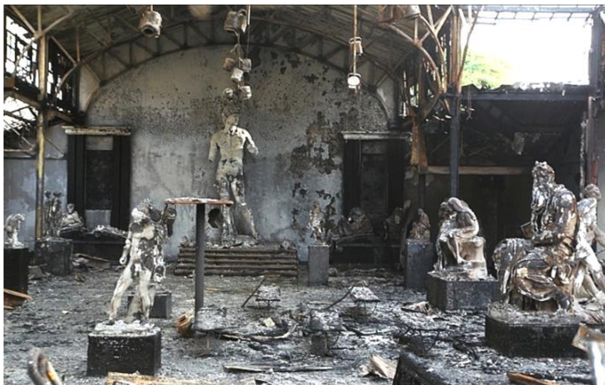
Fig. 20. Estado da coleção de réplicas em gesso do Centro Cultural do Liceu de Artes e Ofícios de São Paulo após incêndio ocorrido em 04 de fevereiro de 2014.
