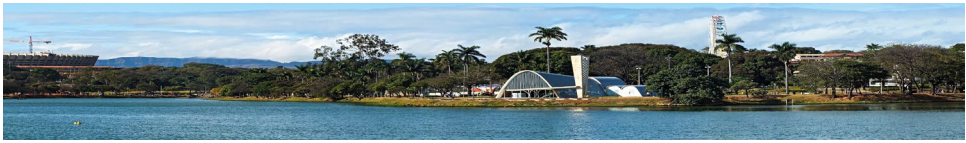
Figura 2 – Igreja São Francisco de Assis, Conjunto Moderno da Pampulha-Belo Horizonte-MG. Crédito: André Borges Lopes
